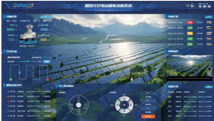
智慧光伏电站智能巡检系统
