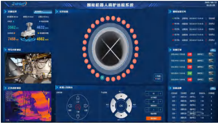
高炉风口巡检机器人系统
