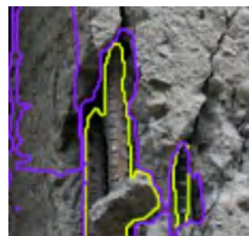
混凝土脱落
